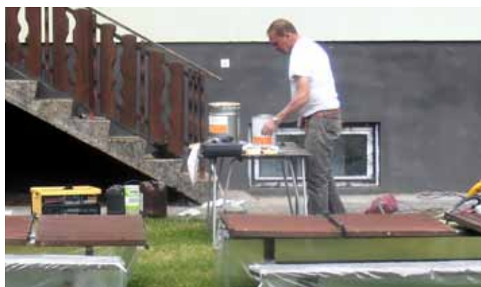
Toni bei der Holzbalkensanierung
