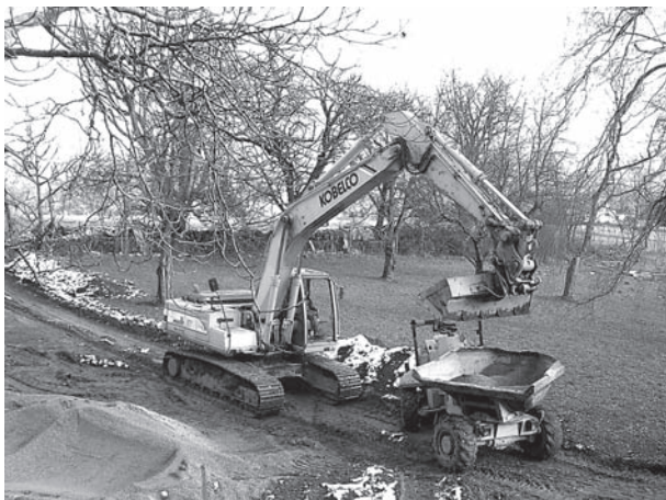
Der Kanalanschluss der Villa St. Radegund ist in Arbeit
